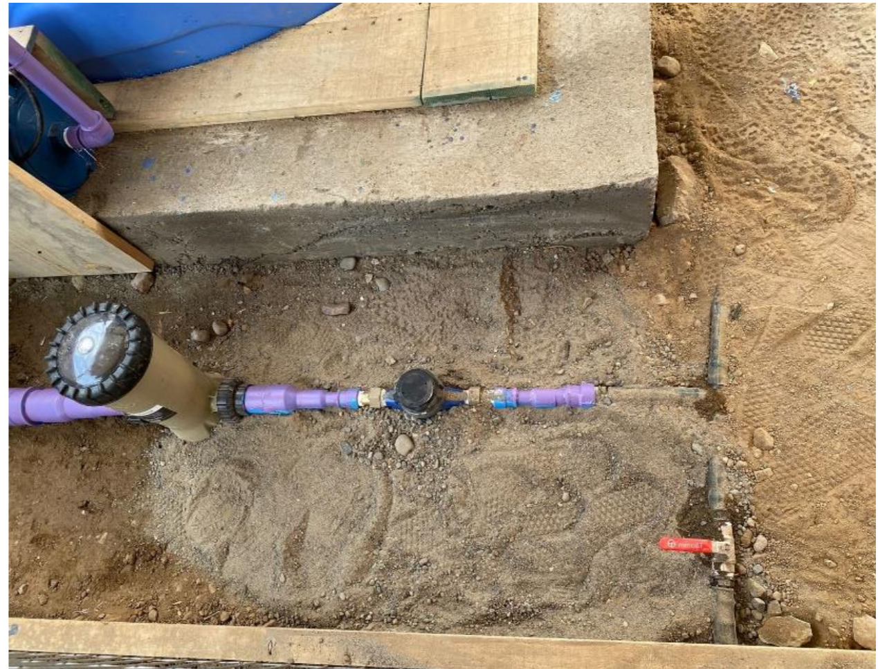
PASO 7 REVISAR CLORADOR CAMBIAR PASTILLA CADA 20.000 L
