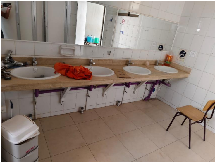
Figura 2: Fotos de los sistemas de bypass bajo los lavamanos.
