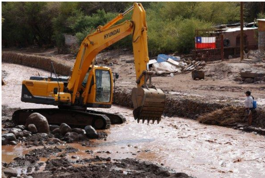
FOTOGRAFÍA 2-5: MAQUINARIA DE VIALIDAD OPERANDO EN EL SECTOR DEL AYLLU DE QUITOR.
