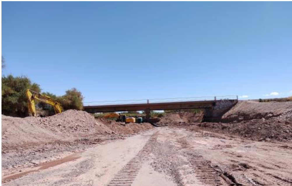
FIGURA 4-95: PUENTE SAN PEDRO
