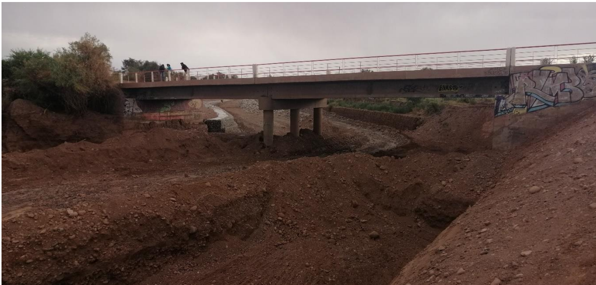
FIGURA 4-24: PUENTE SAN PEDRO DE ATACAMA
