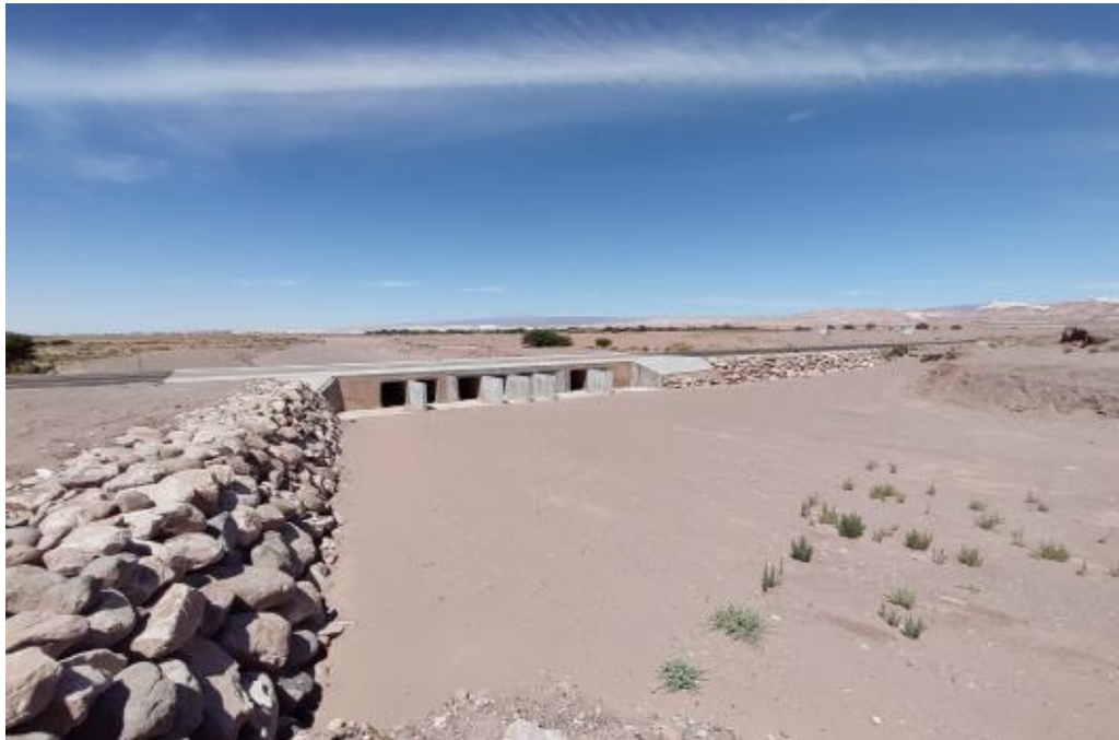
FIGURA 4-97: OBRAS DE ATRAVIESO EN RUTA DE CIRCUNVALACIÓN
