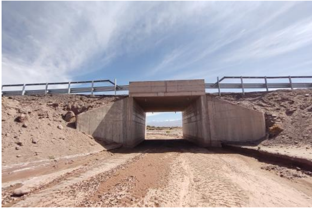
FIGURA 4-96: PASO BAJO NIVEL EN RUTA CIRCUNVALACIÓN
