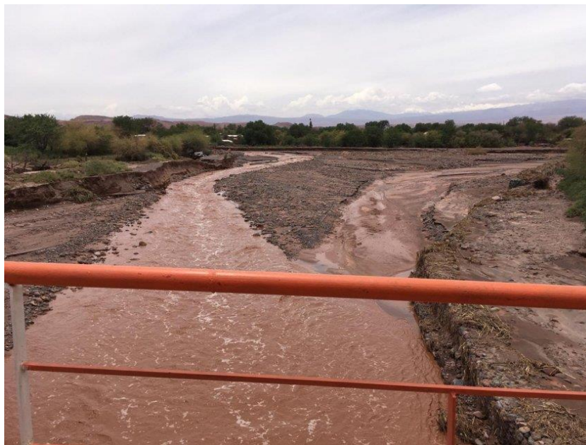
FOTOGRAFÍA 2-9: DAÑOS SOBRE LA INFRAESTRUCTURA
