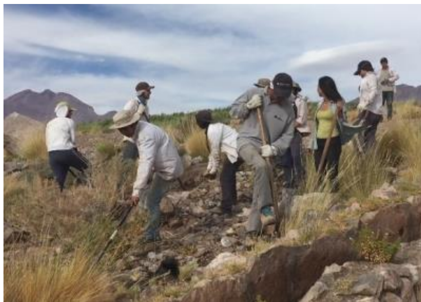
FOTOGRAFIA 1-2: Limpia de Canales Socaire
