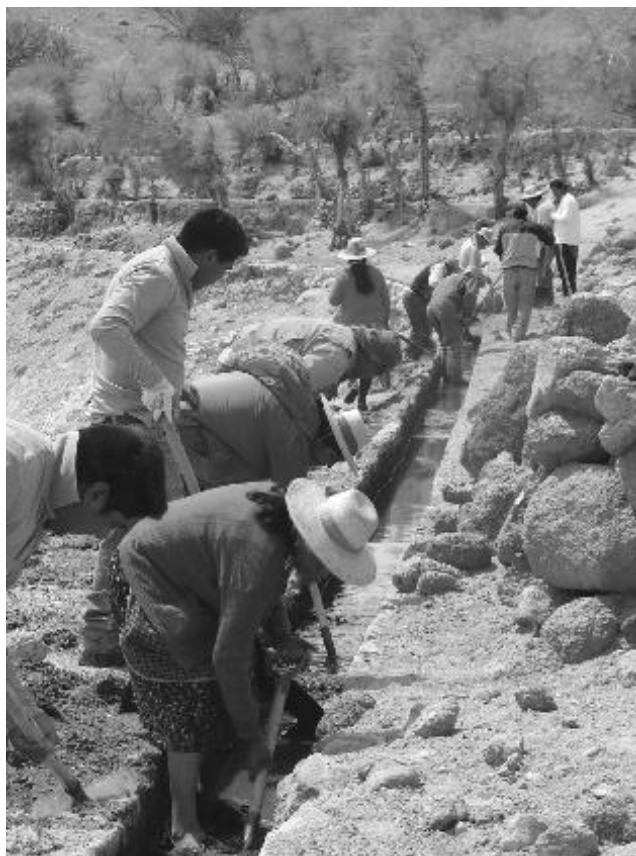
FOTOGRAFIA 1-1: Limpia de Canales Camar
