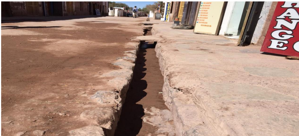
Fotografía N° 4-7: Canal de Condeduque en San Pedro
