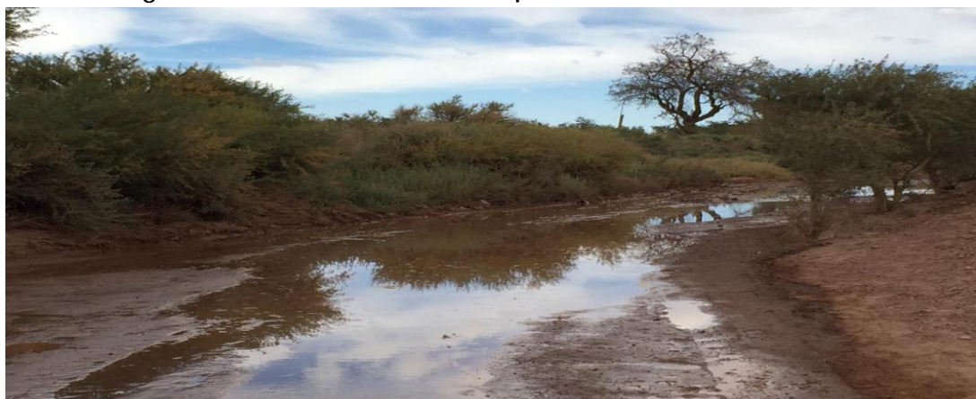
Fotografía N° 4-9: Camino Inundado por Filtración de Canal en Larache
