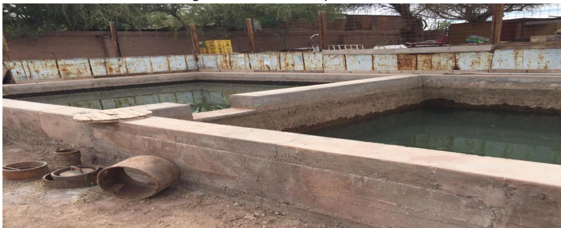
Fotografía N° 4-10: Tranque en Solcor
