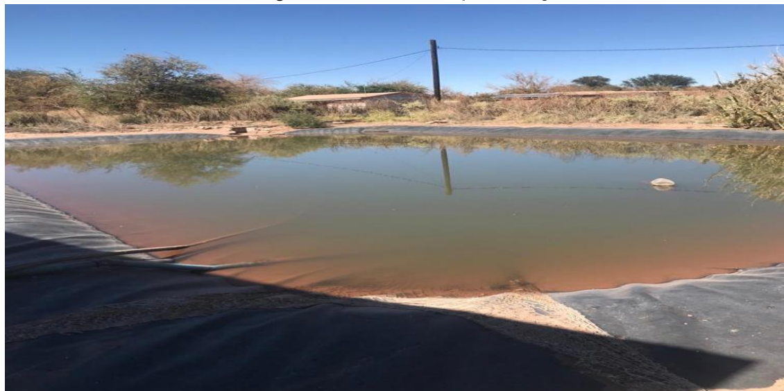
Fotografía N° 4-12: Tranque en Coyo
