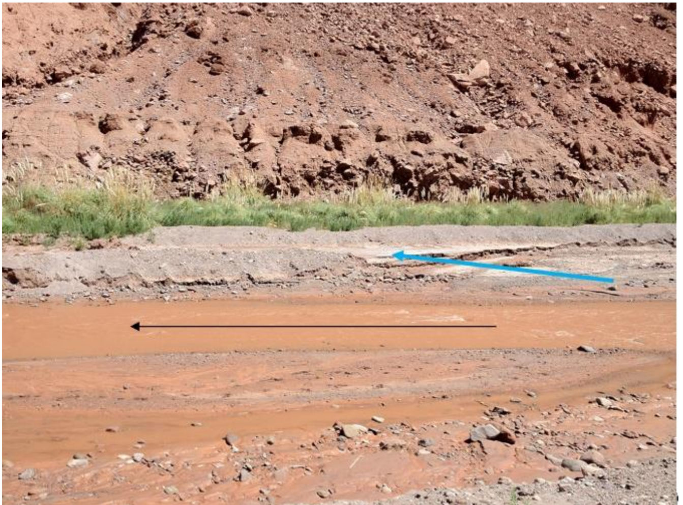
FIGURA 3.2.4.5-1 TOMA DEL CANAL TAMBILLO
