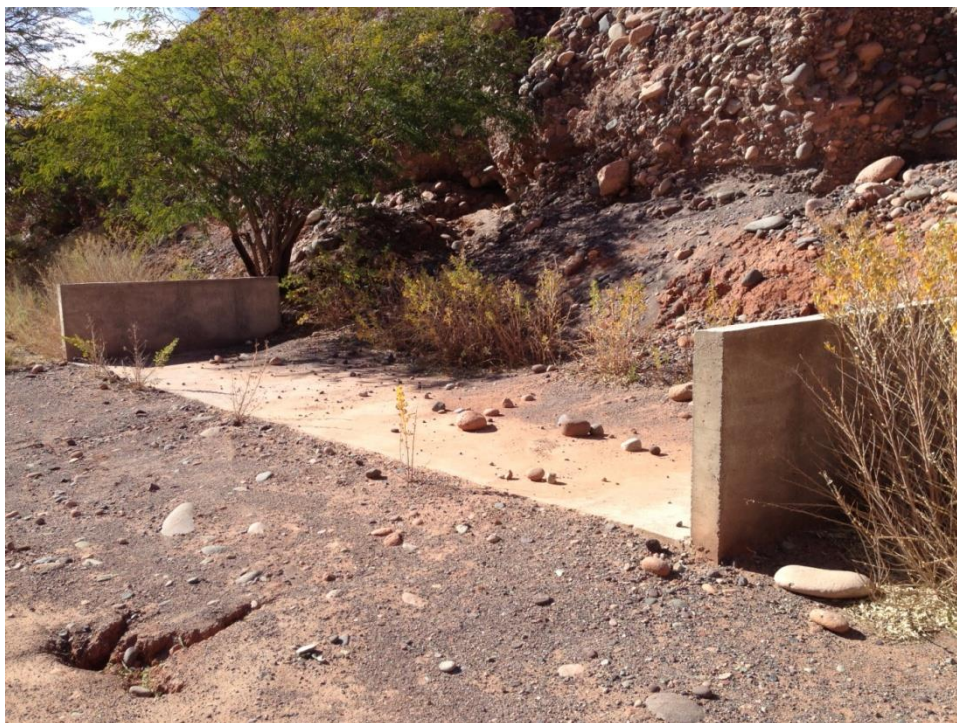
FIGURA 6.6.4.1-1 OBRA TIPO PARA ATRAVIESO DE QUEBRADAS
