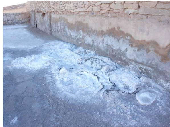
Fotografía 19.- Antiguas piscina de la planta de secado de boratos, actualmente abandonada.
